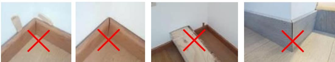
⇒ Sie benötigen Hilfsmittel wie Keile oder Gewichte, um die Wandsockel während des Einbaus an ihrem Platz zu halten. Nach dem Einbau passt die Wandsockel nicht gut an die Wand, der Außenwinkel ist nach dem Einbau offen, ...
